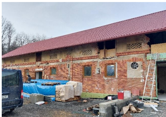
Obr. 29 Budova technického zázemí ve sběrném dvoře
