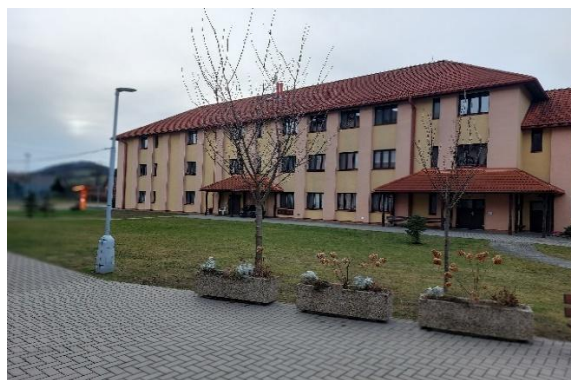
Obr. 27 Bytový dům Dolní Sklenov č.p. 140
